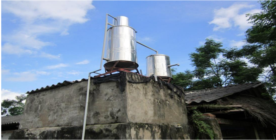
Bể chứa nước
